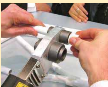
Hàn phụ kiện sử dụng khớp nối - Socket Fusion Welding Method
