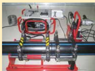
Hàn ống - Pipe Welding
